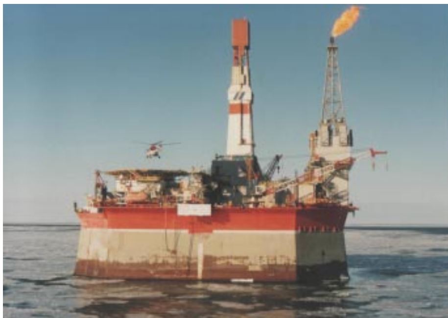
1 Основания и верхние части морских буровых платформ строили на берегу, затем фундаменты затапливали в море, а на них водружали «крыши» — мини-города (фото слева). Ледостойкую буровую платформу «Моликпак» (фото справа) построили в Канаде в начале 1980-х годов и сегодня она качает нефть в Охотском море
